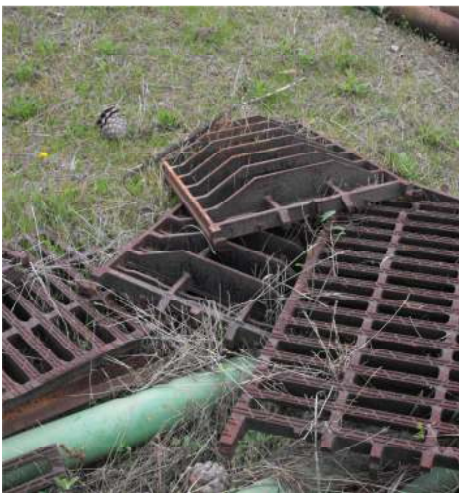
Caditoie per attraversamento stradale
